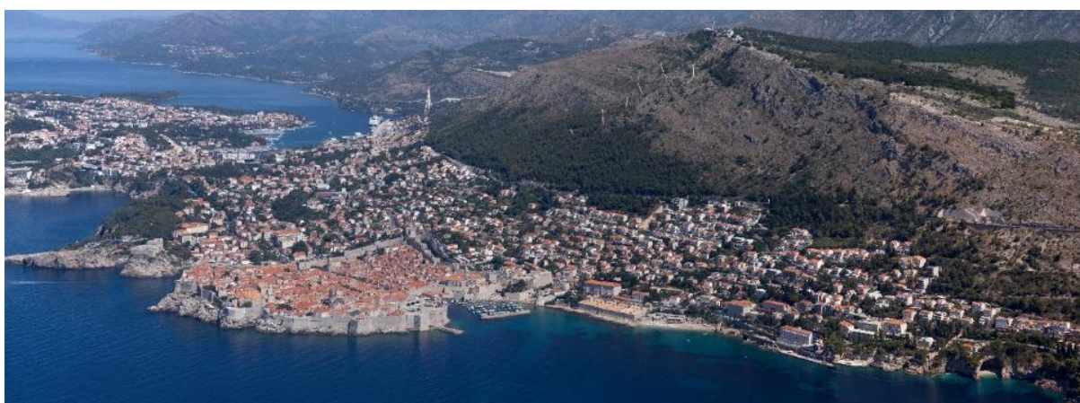
Slika 2.5-4 Jači reljefni rub ( brda zaleđa priobalja i udoline s naseljem Riđica, Mravinjac i Mrčevo; vršni dio padina nad Zatonom; vršni dio padina nad Rijekom Dubrovačkom; Rub gusto izgrađenog dijela grada Dubrovnika i prirodnih padina Srđa)
