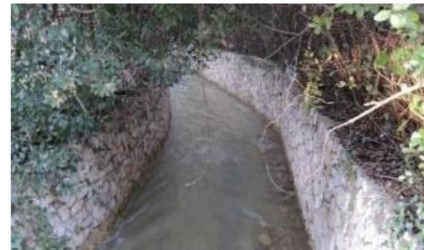
Kanalizirani prirodni vodotoci
